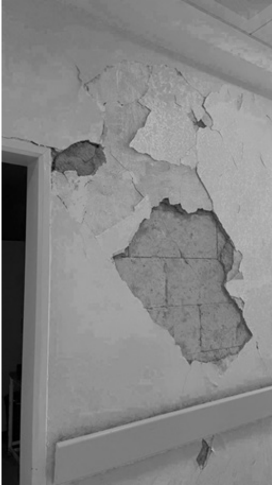
Resim 1. Deprem sonrası hastane duvarları
